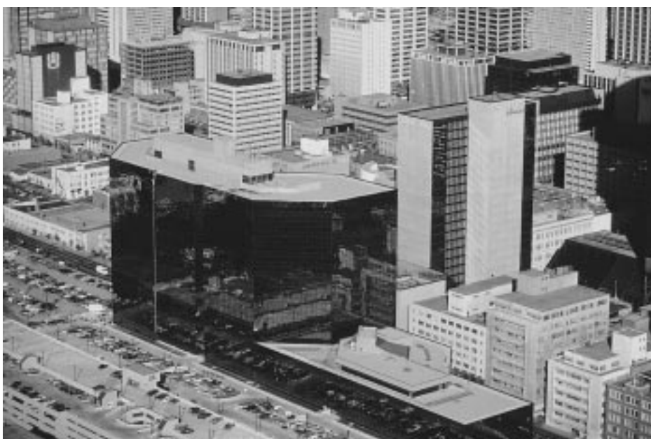
Gulf Canada Square à Calgary, en Alberta – exemple d'efficacité énergétique dans les édifices commerciaux.
