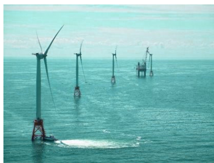
Parc éolien Block Island (Source : ABS Group)
