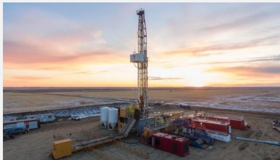
Appareil de forage d'exploration, installation géothermique de DEEP Earth Energy Production, près d'Estevan, en Saskatchewan
