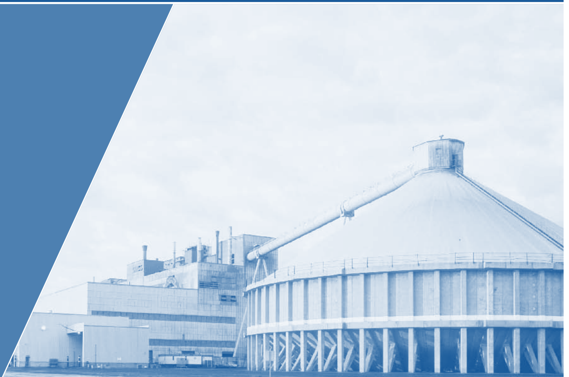
Usine Lafarge de Saint-Constant, Québec
