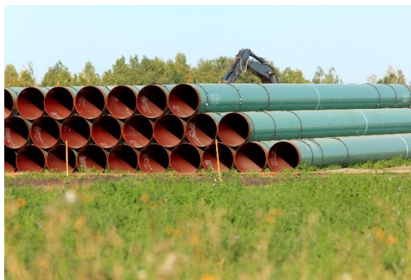
Piles de tronçons de canalisation prêts à être posés d'un bout à l'autre des Prairies
