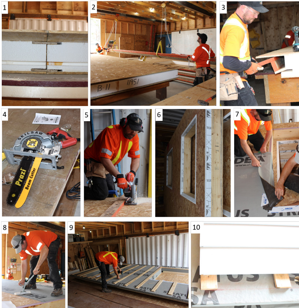
Figure 9-4: Séquence de fabrication du PIS
