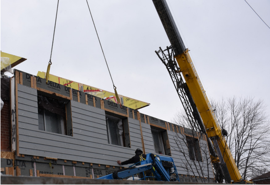
Figure 10-1 : Une grue s'est avérée plus souple et plus rapide qu'un chariot télescopique pour hisser les panneaux du Logement communautaire d'Ottawa (LCO).
