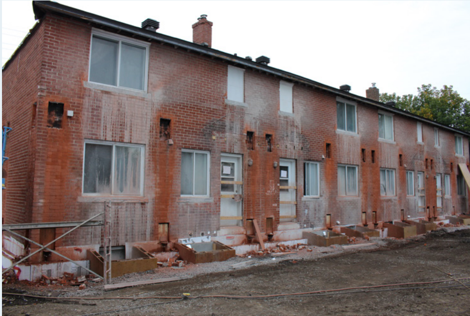
Figure 3-11 : Préparation d'un bâtiment pour une rénovation REEEP. Auvents, perrons, avant-toits enlevés, appuis de fenêtre coupés à ras, unités de briques enlevées pour réaliser les connexions structurelles.
