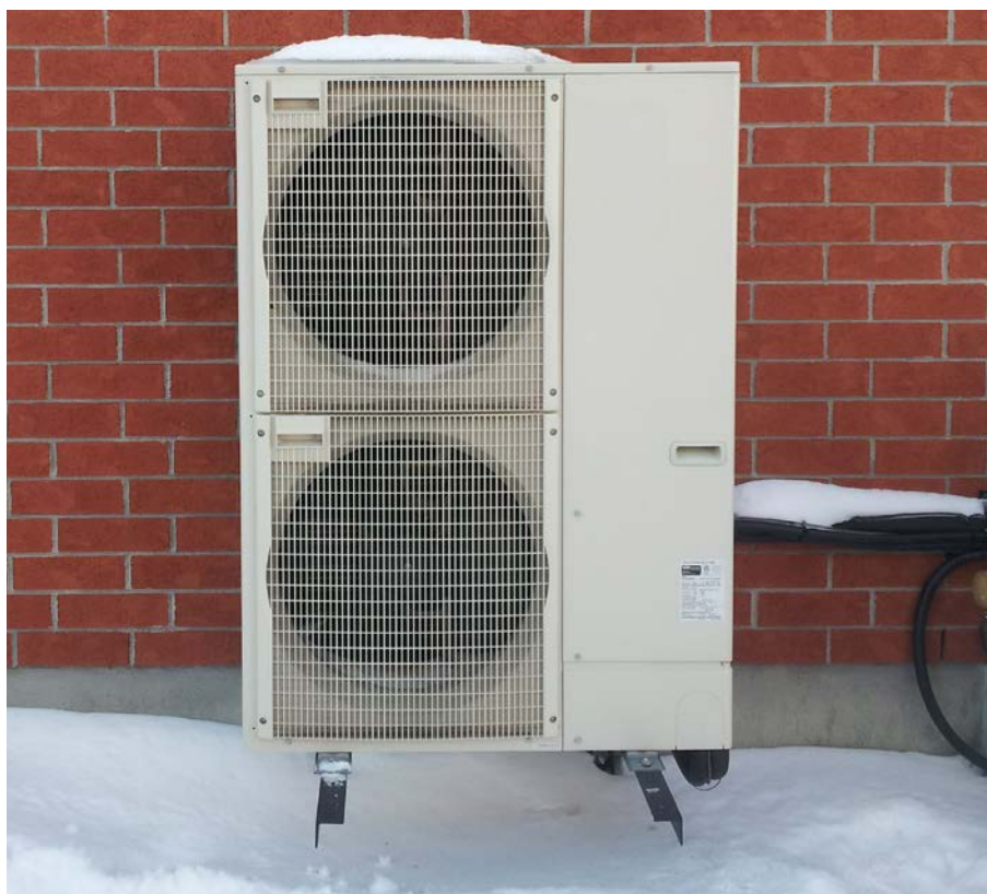
Figure 23 : Image d'une TCAF installée au Centre canadien des technologies résidentielles à Ottawa. Référence photographique: Ressources naturel Canada
