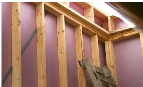
Figure 8 : Système d'isolation à la mousse rigide utilisé dans une maison de démonstration de Winnipeg pour remplacer le parement de bois extérieur ainsi que comme pare-air, 2015. Référence photographique: Gary Proskiw
