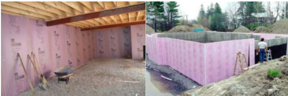
Figures 16 et 17 : Exemple des systèmes de fondations du fabricant, avec isolant en panneaux rigides à l'extérieur et à l'intérieur sous le niveau du sol. Références photographiques: Owens Corning Canada
