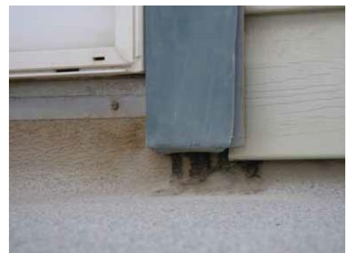
Figure 2 Signes de migration du plastifiant d'une membrane autocollante vers la membrane liquide à base d'uréthane.
