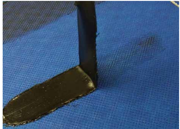
Figure 3 Test d'adhérence du produit d'étanchéité montrant une défaillance de l'adhésif d'une membrane synthétique autocollante perméable à la vapeur.
