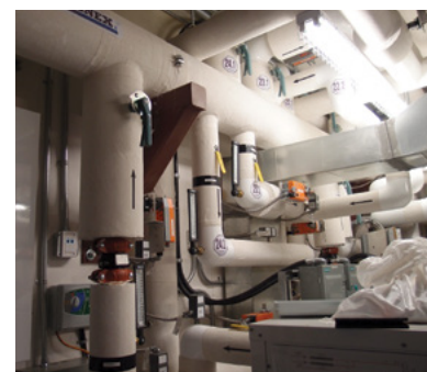
Figure 4. Isolation des conduits du système de CVCA
