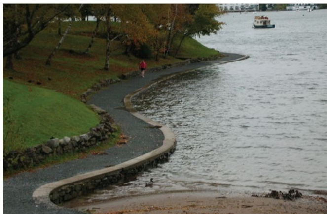
FIGURE 14 : Mesures structurelles sur le littoral en Nouvelle-Écosse. Photo gracieuseté de M. Davies.
