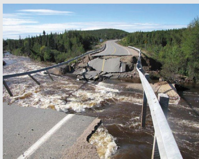
FIGURE 4: Emportement par les eaux de l'autoroute et du pont près de Port Rexton, T.-N.-L. Photo gracieuseté des Services des incendies et des urgences de Terre-Neuve-et-Labrador.
