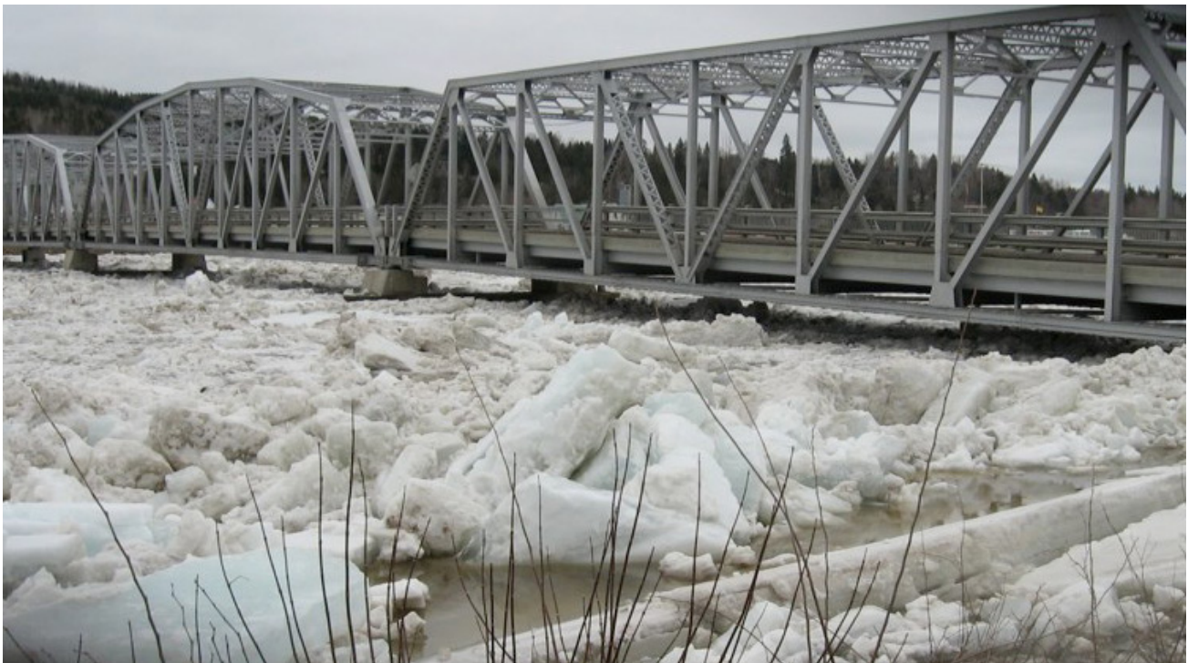
Figure 12 : Un embâcle force l'ordre d'évacuation à Perth-Andover au printemps 2015. (Source : Caserne de pompiers de Perth-Andover)
