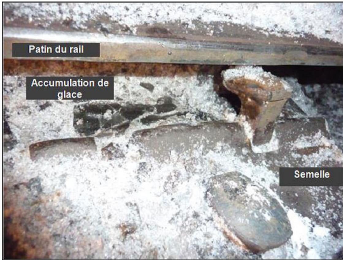
Figure 15 : Portion de la voie ferrée à Fernie, en Colombie-Britannique, montrant l'accumulation de glace. (Source : Bureau de la sécurité des transports du Canada)
