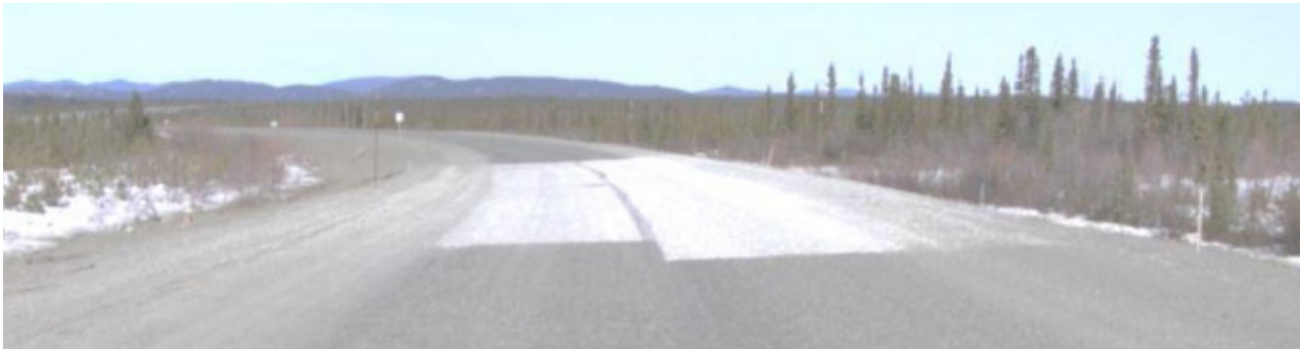
Figure 11 : Section d'essai de traitement de surface à albédo élevé (en tons clairs). (Source : Paul Murchison)
