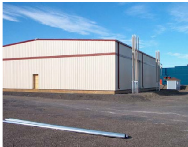
Figure 13 : Fondation à thermosiphon à courbe plate dans un garage d'entretien aéroportuaire à Inuvik, dans les Territoires du Nord-Ouest. (Source : Igor Holubec)
