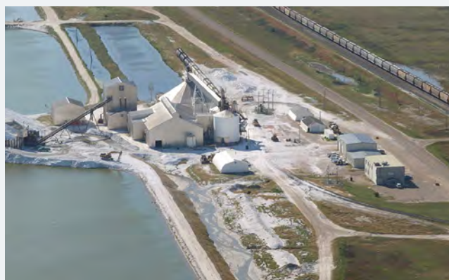
FIGURE 5 : Mine de sulfate de sodium de Chaplin, au sud-ouest de la Saskatchewan (Photo gracieusement fournie par la Saskatchewan Mining and Minerals Inc.).
