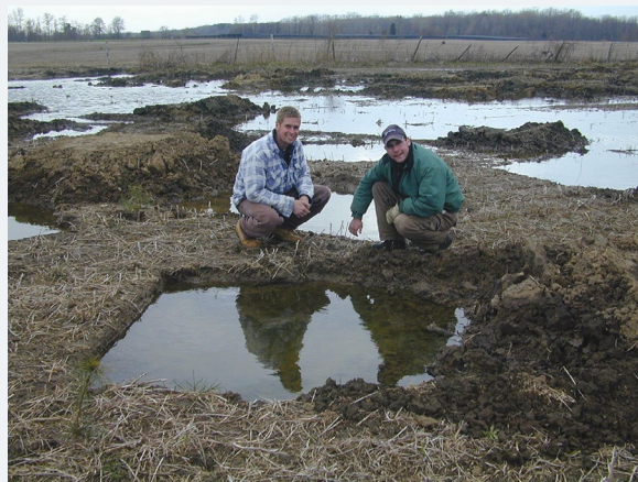
FIGURE 10 : Une technique de remise en état de creux et de buttes a été utilisée pour reproduire le paysage caractéristique des forêts anciennes créé par la décomposition des arbres tombés. Les creux ont fourni des endroits propices à la reproduction aux amphibiens et aux insectes, des aires d'alimentation et d'abreuvement aux oiseaux et aux mammifères, et ont contribué à maintenir les systèmes de recharge des eaux souterraines. Les buttes, dont les sols sont bien drainés et oxygénés, ont favorisé, entre autres, la croissance rapide des chênes rouges et blancs (photo publiée avec l'aimable autorisation de B. Craig ©).
