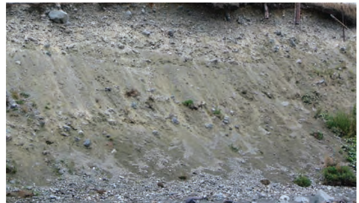
FIGURE 14 : a) Érosion côtière au Parc provincial Union Corner, dans l'Île-du-Prince-Édouard et b) érosion active de l'escarpement à Middle Cove, à Terre-Neuve-et-Labrador.
