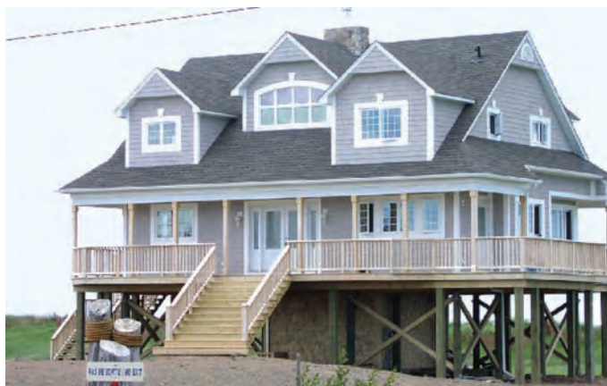
FIGURE 18 : La construction de bâtiments sur pilotis est un exemple d'adaptation réduisant la vulnérabilité aux ondes de tempête. Grand-Barachois (près de Shediac), détroit de Northumberland, sud-est du Nouveau-Brunswick. Photo gracieuseté d'Armand Robichaud.
