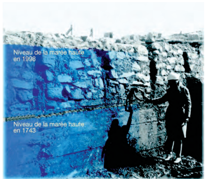
FIGURE 10 : Élévation du niveau de la mer à Louisbourg, en Nouvelle-Écosse ( tiré de Ressources naturelles Canada, 2006c).
