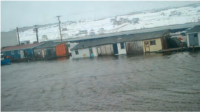
FIGURE 23 : Inondation à St. Lawrence (Terre-Neuve-et-Labrador) due à une onde de tempête de la baie Placentia provoquée en février 2004 par un vent du sud-ouest (tiré de Southern Gazette, Marystown, Terre-Neuve-et-Labrador).
