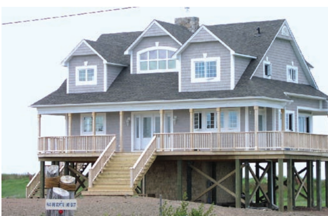
FIGURE 18 : La construction de bâtiments sur pilotis est un exemple d'adaptation réduisant la vulnérabilité aux ondes de tempête. Grand-Barachois (près de Shediac), détroit de Northumberland, sud-est du Nouveau-Brunswick. Photo gracieuseté d'Armand Robichaud.
