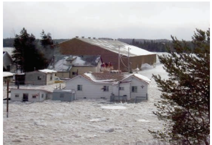
FIGURE 22 : Inondation causée par un embâcle, à Badger, (Terre-Neuve-et-Labrador). Photo gracieuseté de Brian Hawel.
