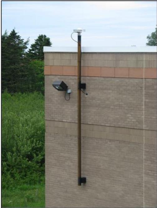
Figure 6 : Mât d'antenne fixé à un mur porteur à l'aide de boulons pour la fixation
