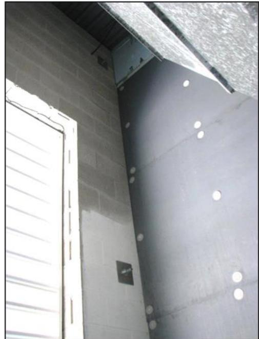
Figure 9 : Boulons traversants dans le béton
