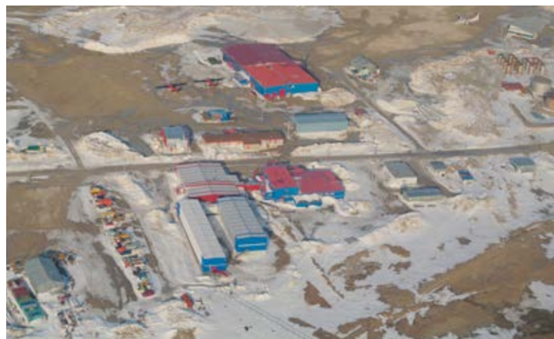
Vue aérienne de l'installation du PPCP à Resolute, au Nunavut, en 2014
