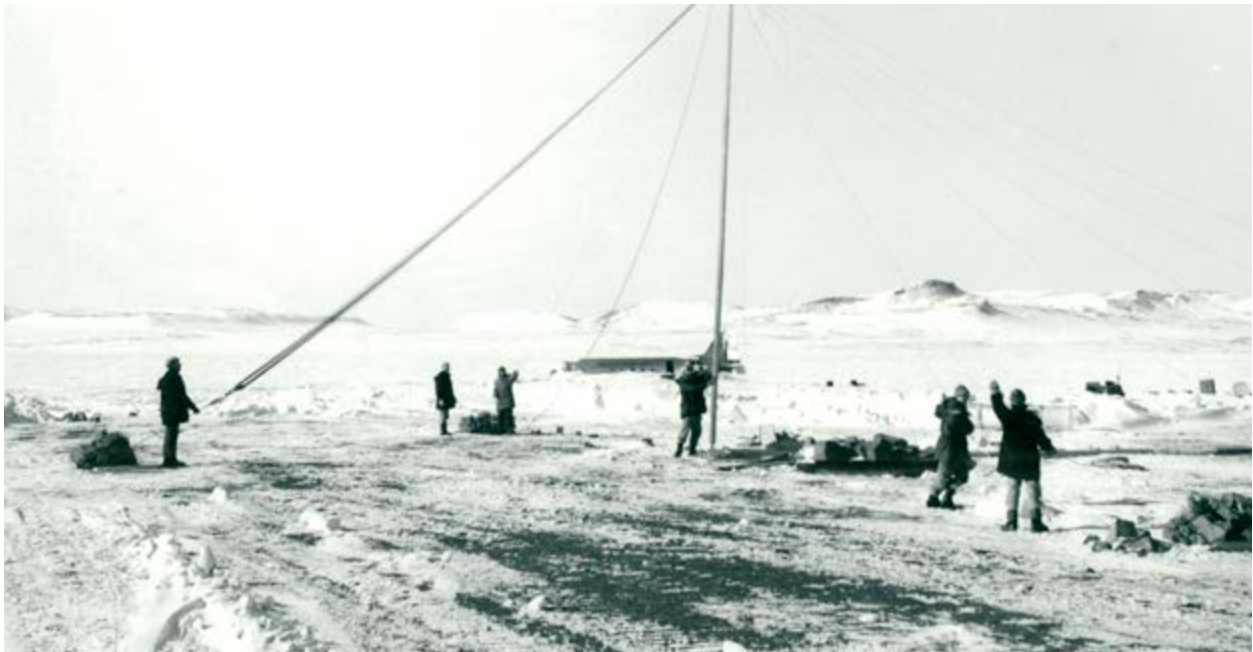
Érection d'un mât de transmission pour le système de navigation de la station météorologique Isachsen, sur l'île Ellef Ringnes, en 1959
