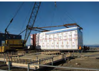
Préparation à l'installation du PPCP en vue de l'installation des modules (Resolute, au Nunavut).
