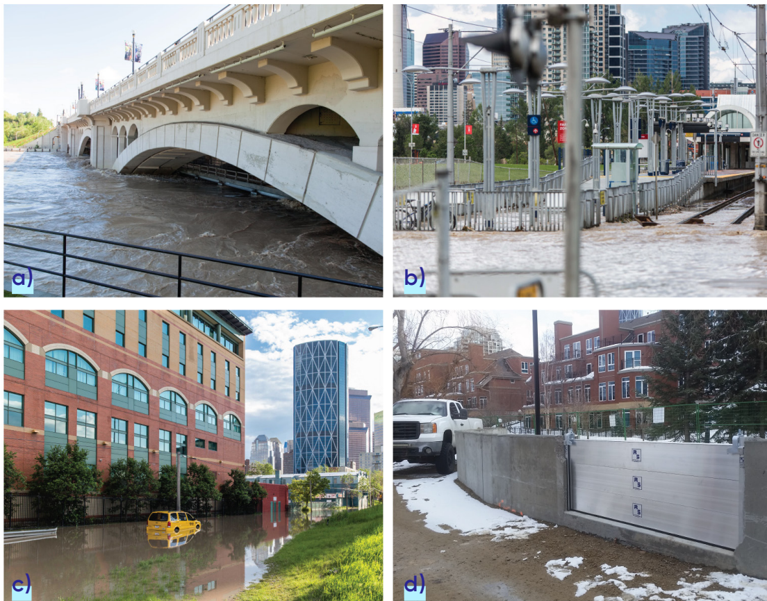
Figure 4.5 : Dommages et rétablissement suite aux inondations de Calgary en juin 2013 : a) niveaux d'eau presque records sur la rivière Bow, b) perturbation des transports urbains, c) inondation du centre-ville, et d) mur d'endiguement de West Eau Claire. Photos gracieuseté de : Ville de Calgary.
