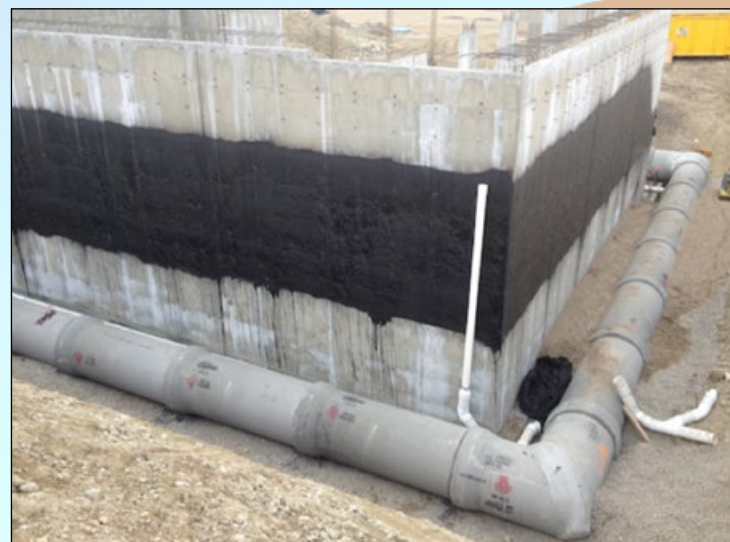
Figure 1. Tube préfabriqué d'un diamètre de 750 mm.
