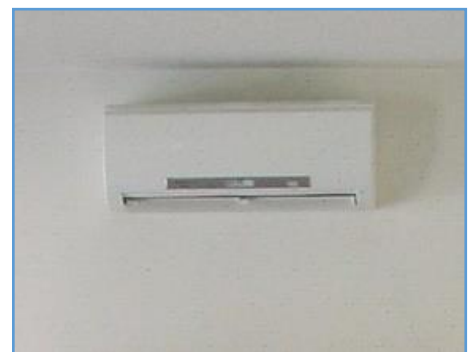
Figure 9 : Unité intérieure installée au mur
