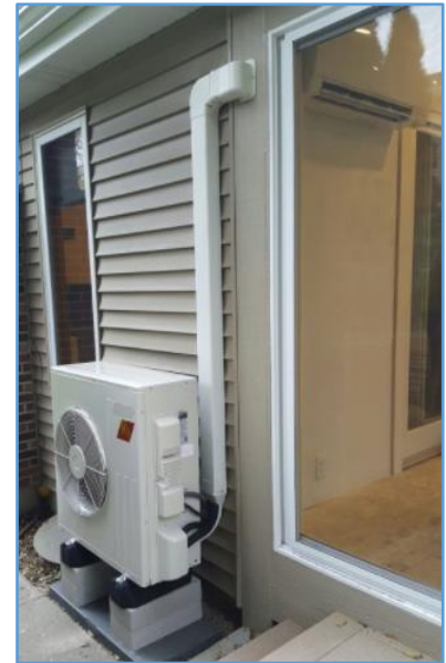
Figure 7 : Thermopompe à air mini-bibloc sans conduit
