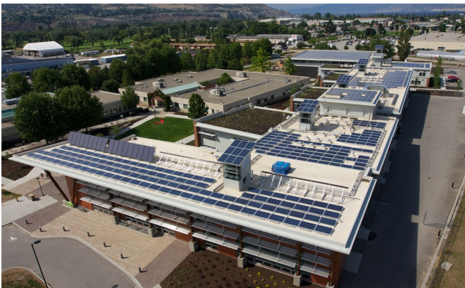
Figure 1: Système solaire PV de 260 kilowatt installé sur le toit du Collège Okanogan en Colombie-Britannique afin d'atteindre la cible ambitieuse du «Living Challenge» et contribuer à former des étudiants dans le domaine des pratiques de constructions durables (Photo: Skyfire Energy).
