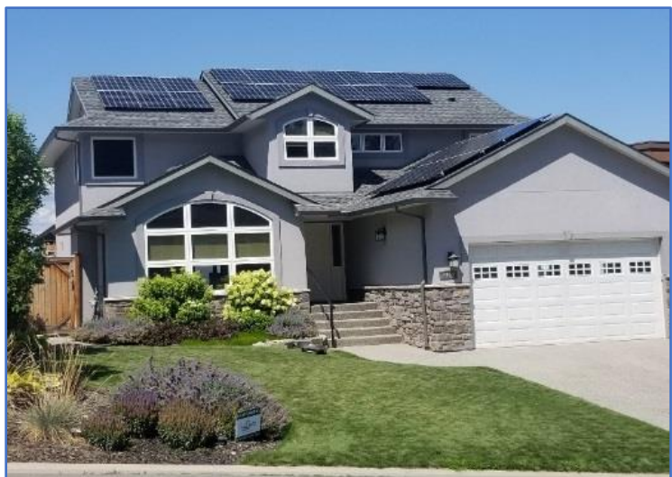
Figure 13 : Système de matériel solaire PV installé sur un toit dont les champs de panneaux solaires sont exposés au Sud et à l'Ouest - avec l'aimable autorisation de Riverside Energy Systems
