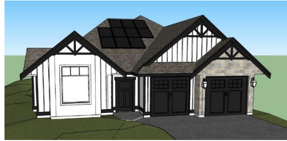
Figure 4 : Lucarne Sud éliminée, remplacée par un champ de panneaux solaires PV de 3 kWc – avec l'aimable autorisation de Sonbuilt Homes
