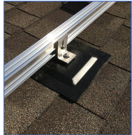
Figure 23 : Ancrages scellés et vissés au revêtement du toit, avec la rampe installée - avec l'aimable autorisation de Riverside Energy Systems
