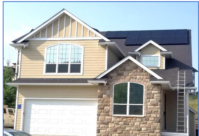
Figure 28 : Champ de panneaux solaires de 3,5 kWc à cellules monocristallines, modules entièrement noirs
