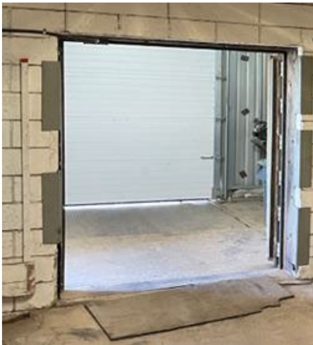
Figure 16 – exemple d'une porte de poudrière de type-1 renforcée par des équerres en acier
