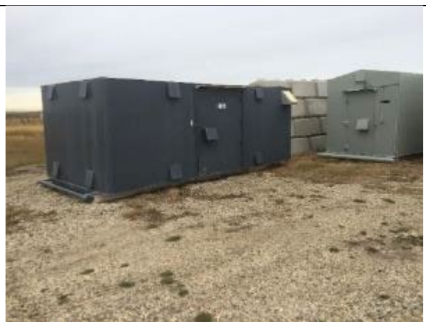
Figure 8 – exemple de poudrière de type-4
