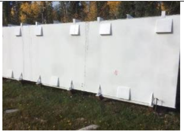
Figure 6 – exemple de poudrière de type-4
