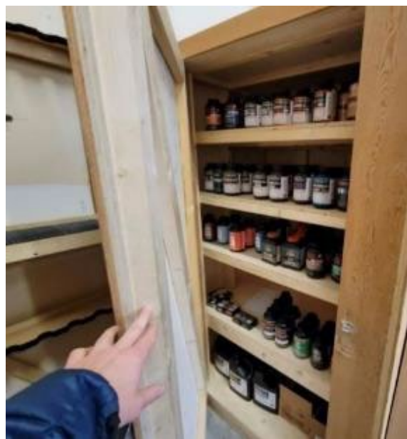
Figure 23 – exemple de poudrière de type-13
