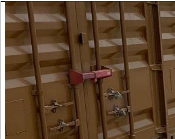
Figure 27 - exemple d'empêchement des barres de maintien verticales sur une poudrière de Type-16
