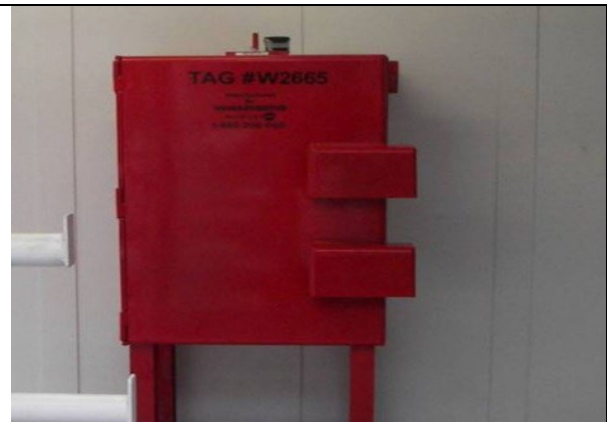
Figure 10 - exemple de poudrière de type-6
